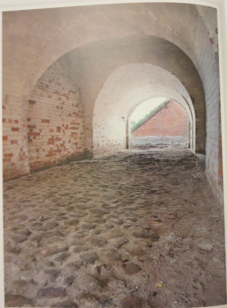
Senasis grindinys šaudmenų sandėlio kazematuose The old paving in the casemates of ammunition warehouse
